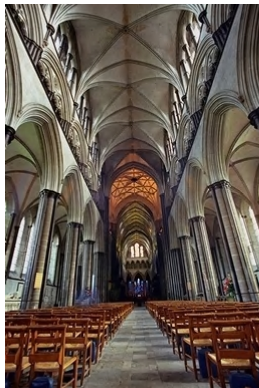
Bóveda de crucería
